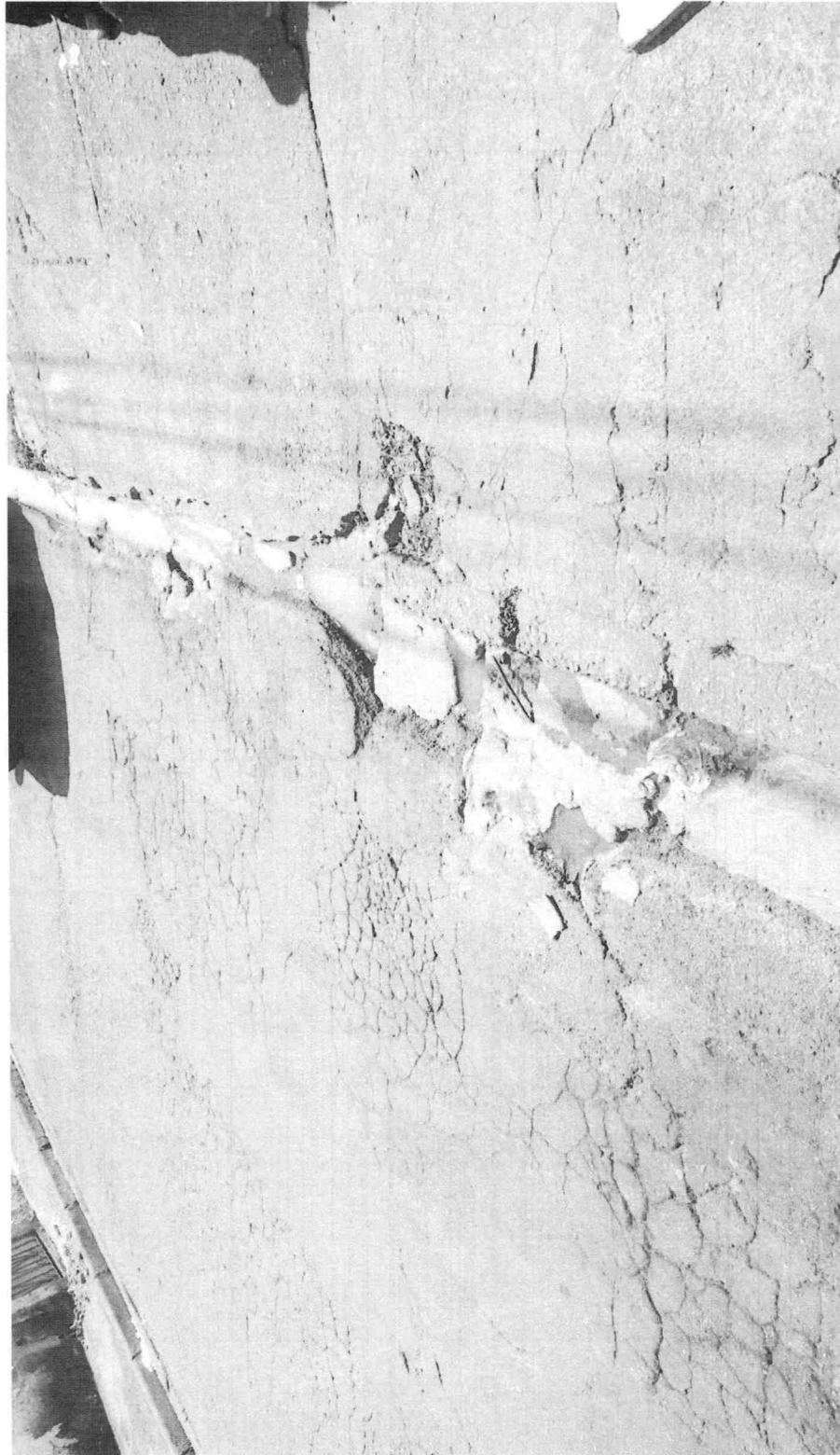
RECONSTRUÇÃO DE SARJETA NA RUA SANTA PERPÉTUA, EM FRENTE AO N° 251, VILA SAGRADO CORACAO DE MARIA.
