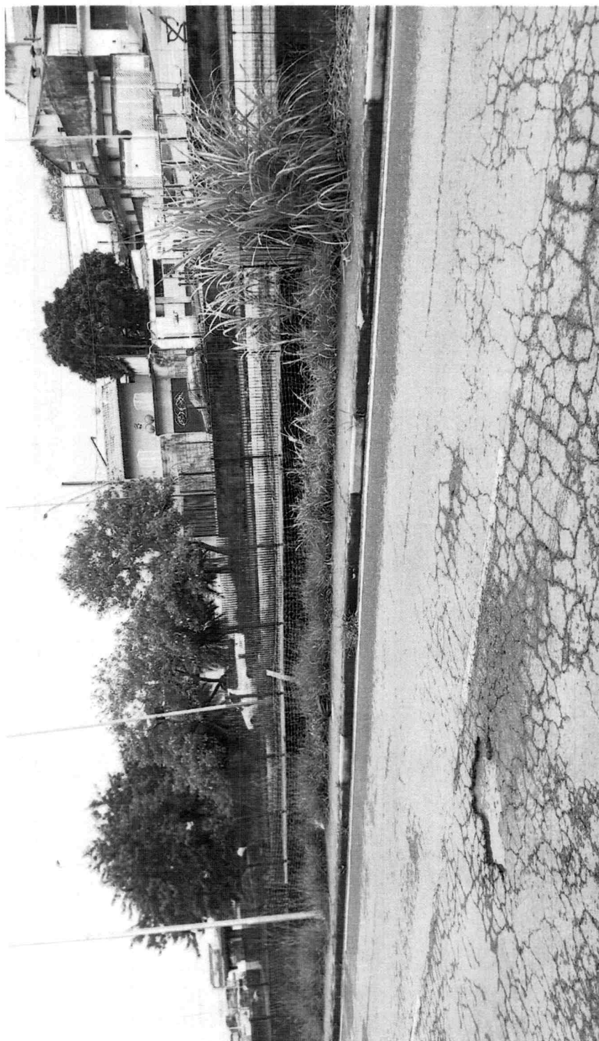
MANUTENÇÃO E RECOLOCAÇÃO DO GRADIL LOCALIZADO NA AV. JÚLIO SIMÕES, EM FRENTE AO Nº 1160, BRÁS CUBAS
