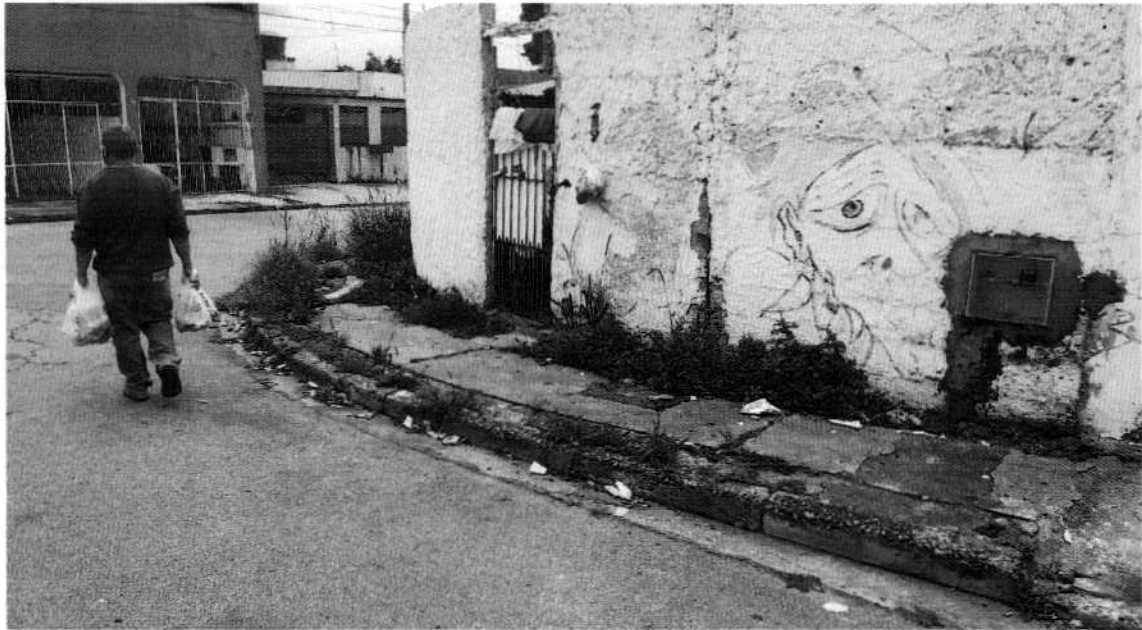
CAPINAÇÃO DE CABEÇA DE GUIAS E RASPAGEM DE SARJETA EM TODA A EXTENSÃO DA RUA SILVESTRE, CONJUNTO DO BOSQUE.
