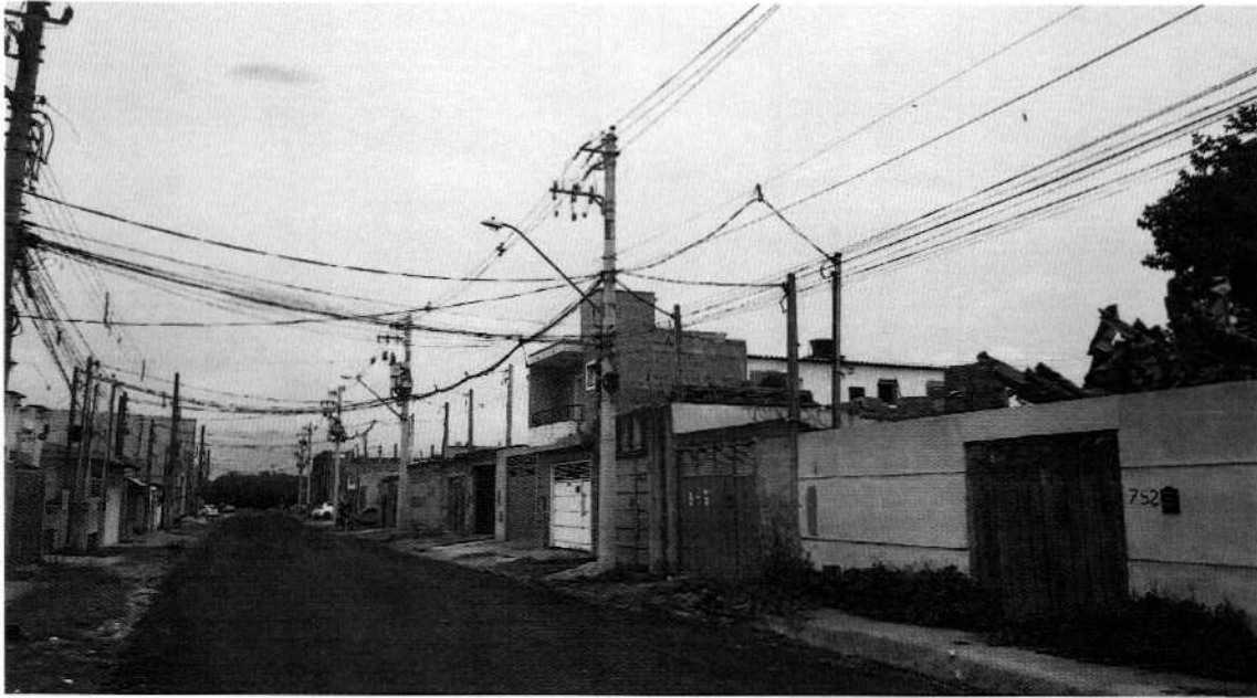
INSTALAÇÃO DE BRAÇOS COM LÂMPADAS NOS POSTES DA AV. AMÉRICA, NO TRECHO QUE COMPREENDE A ENTRADA RUA CEILÃO PARA O RIO JUNDIAÍ.
