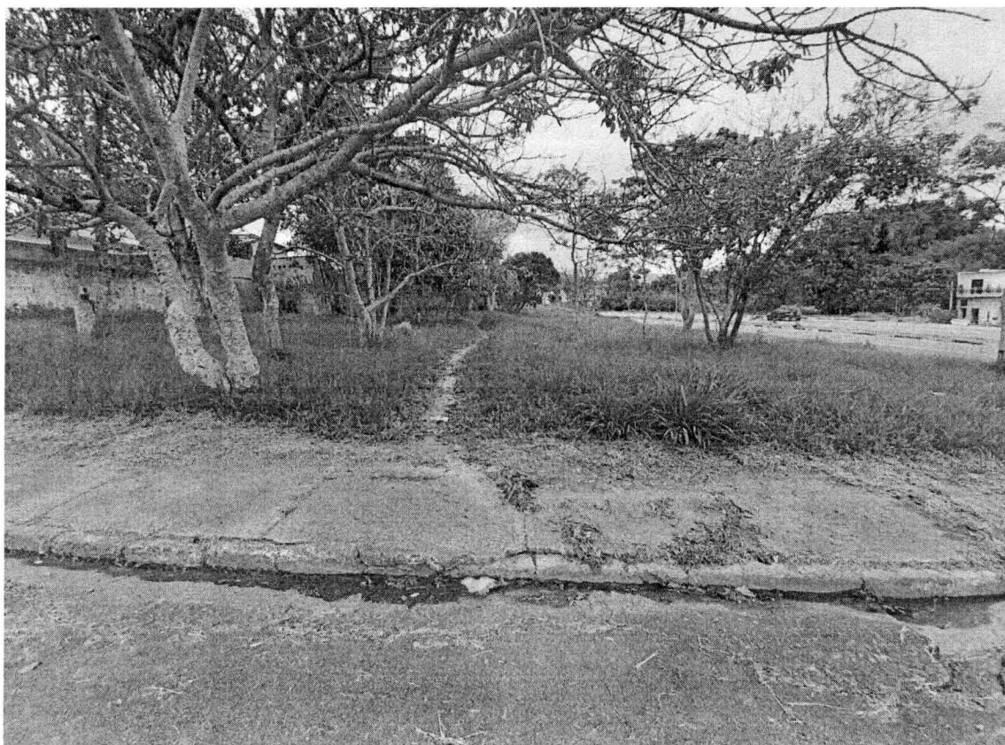
Construção de passagem para pedestre na faixa que interliga a Rua Carolina Andreozzi com a Rua Silvio Vieira, Vila da Prata.
