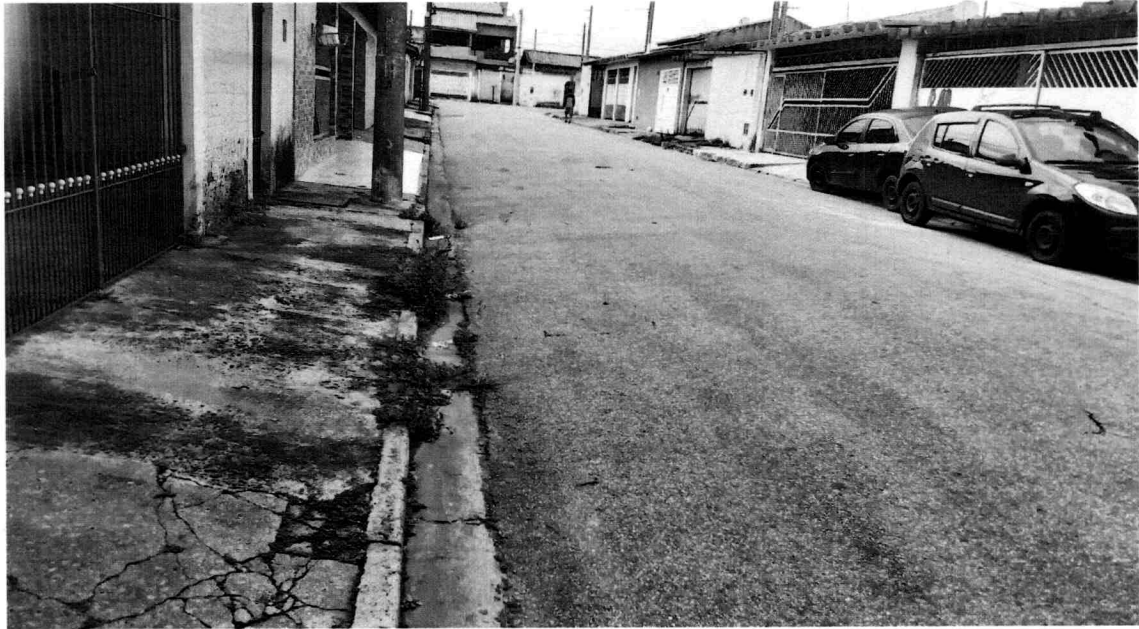
Capinação de cabeças de guia e raspagem de sarjeta em toda a extensão da Rua do Cipreste, Conjunto Residencial do Bosque.
