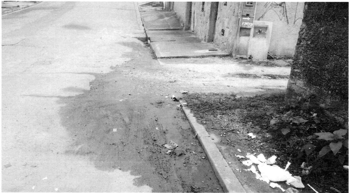
Raspagem de sarjeta na Rua José Secundino Leite, ao lado do Nº. 108.
