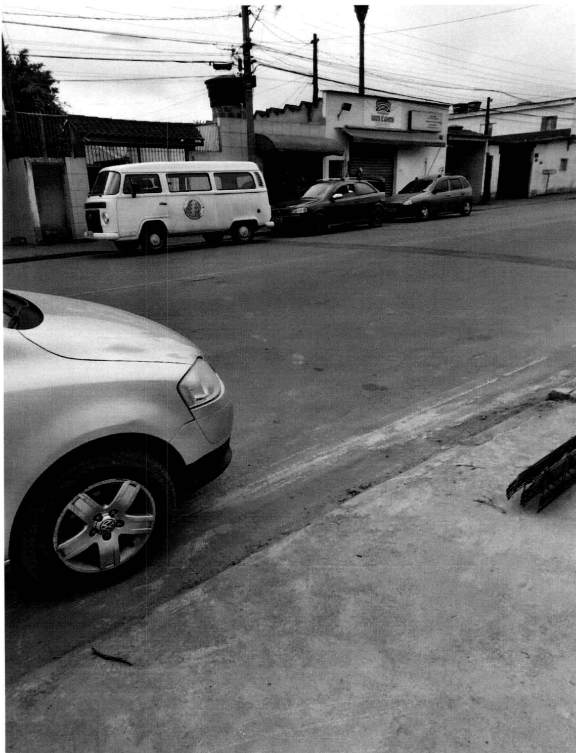
INSTALAÇÃO DE REDUTOR DE VELOCIDADE DO TIPO LOMBADA NA RUA RICIERI BERTAIOLLI JUNIOR À ALTURA DO N° 34, PARQUE DAS VARINHAS.
