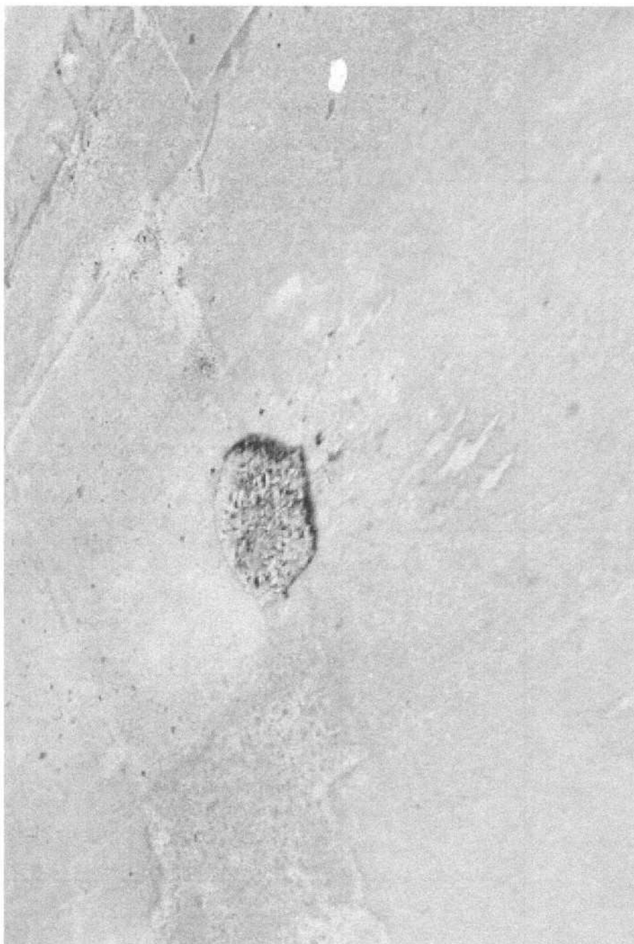
TAPA-BURACO EM TODA EXTENSÃO DA RUA DARCI PEREIRA, JARDIM PLANALTO – MOGI DAS CRUZES
