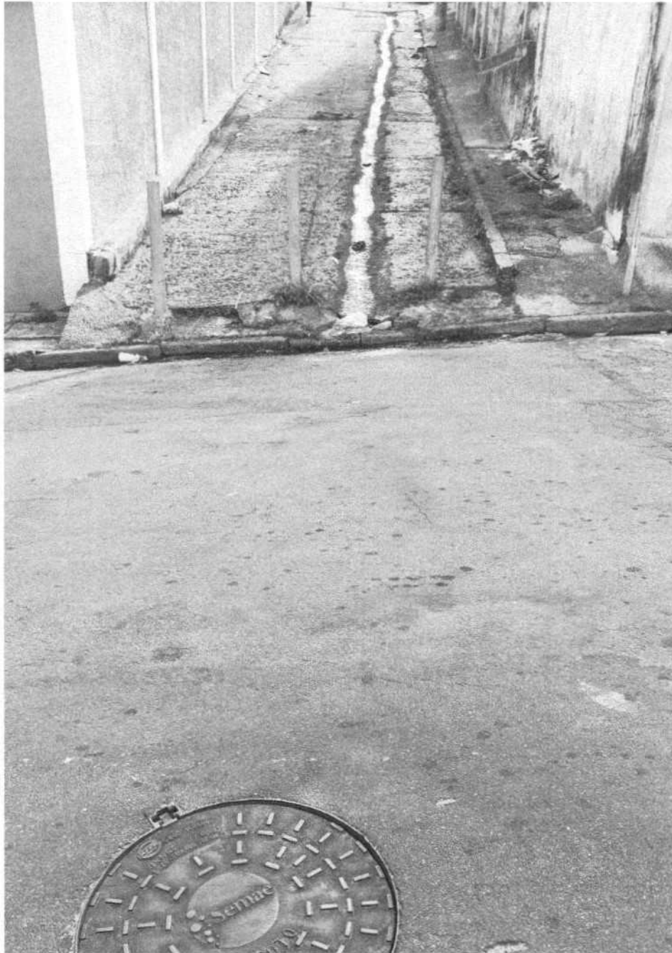
IMPLANTAÇÃO DE LIXEIRA PÚBLICA NA VIELA DA RUA JOAQUIM DA SILVA COUTO, AO LADO DO Nº 182, VILA PAULISTA.
