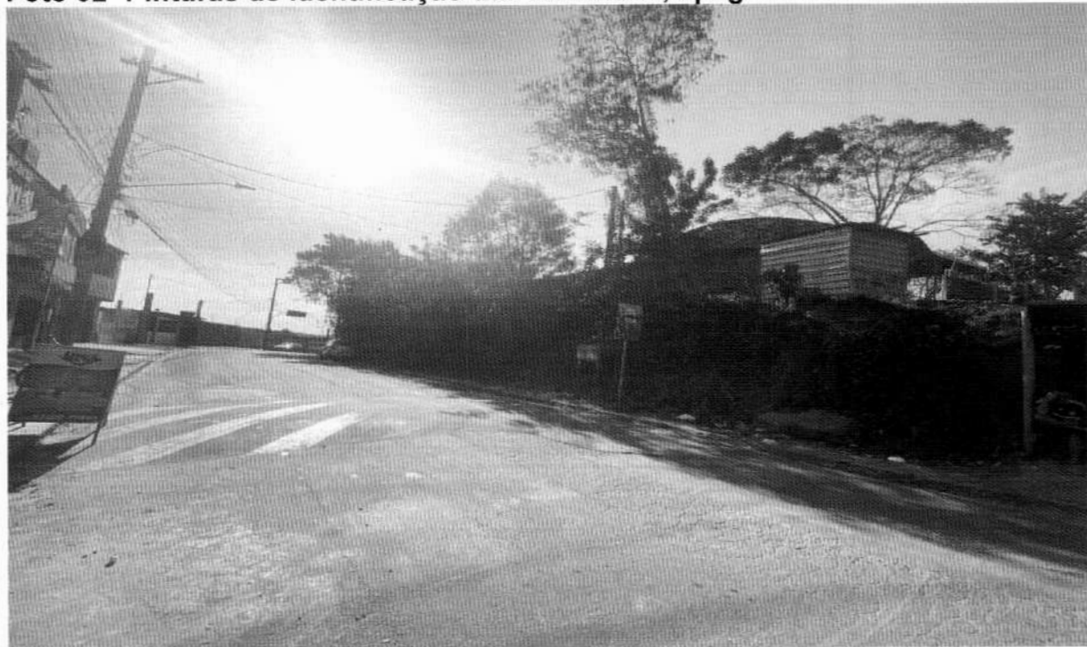
Foto 02- Pinturas de identificação das lombadas, apagadas.
