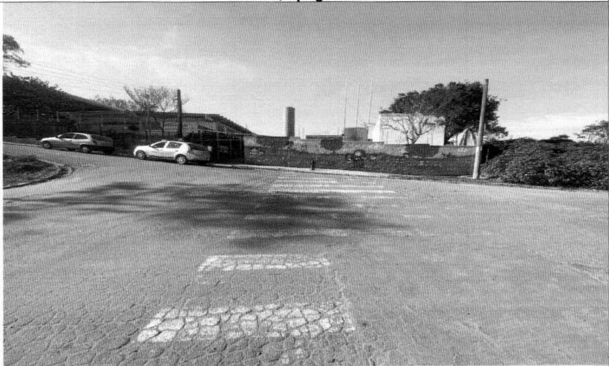
Foto 02- Pinturas de identificação das lombadas, apagadas.
