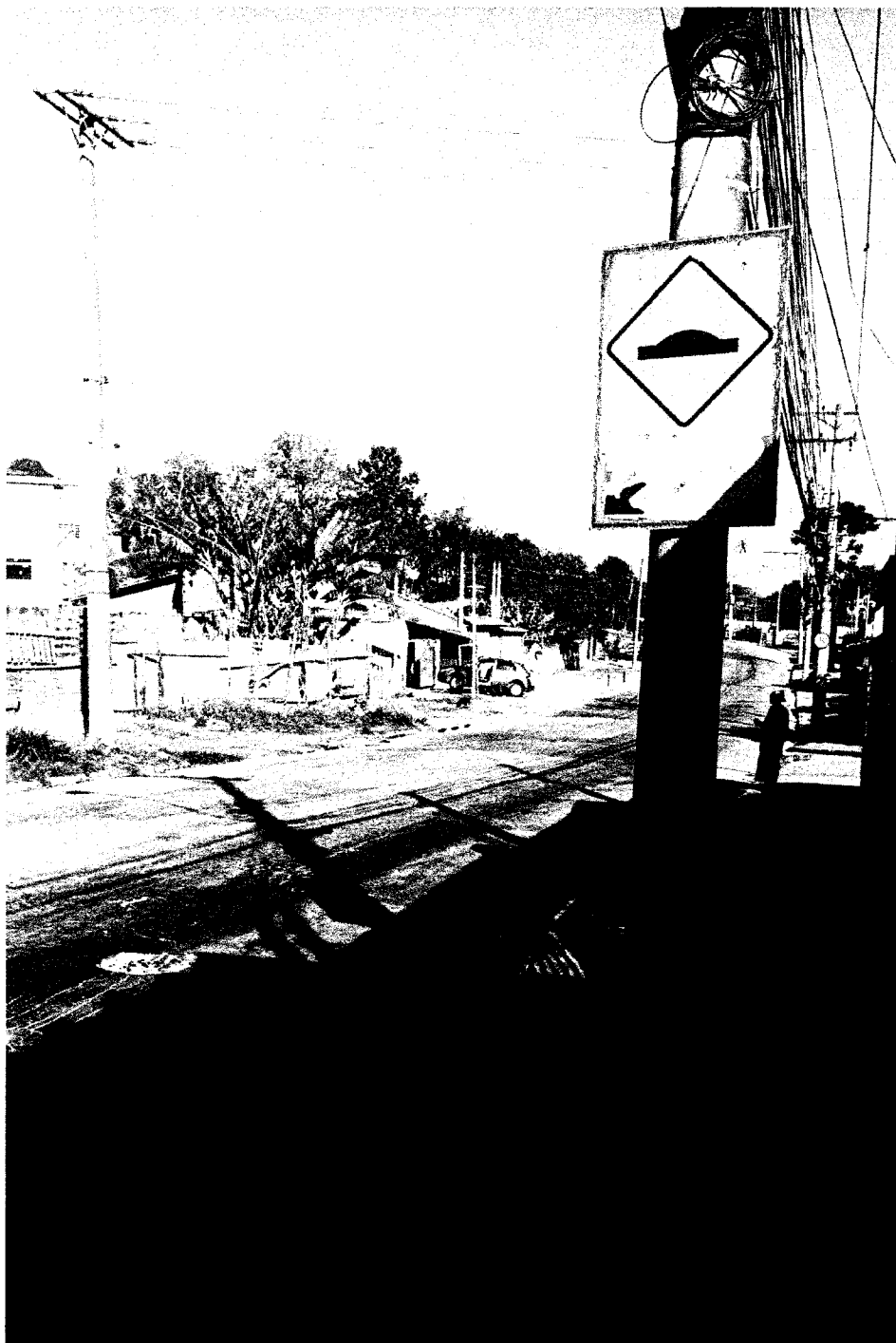
INSTALAÇÃO DE REDUTOR DE VELOCIDADE DO TIPO LOMBADA NA RUA JOÃO DA CRUZ BRAGA, EM FRENTE AO N° 126, BRÁS CUBAS.
