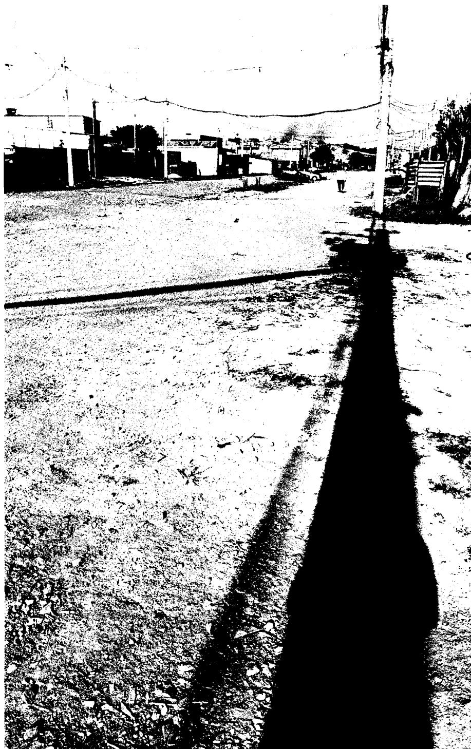
IMPLANTAÇÃO DE REDE DE ÀGUA E ESGOTO NO FINAL DA AV. PANTALEÃO TRANDAFILOV FILHO, N° 590 AO N° 2019.
