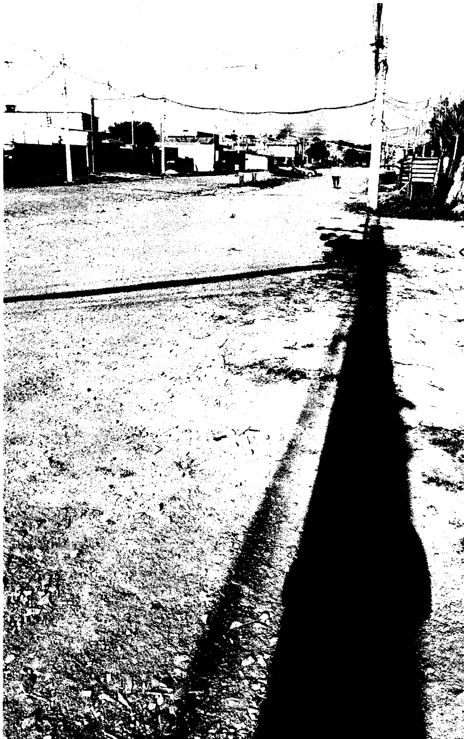
IMPLANTAÇÃO DE REDE DE ÁGUA E ESGOTO NO FINAL DA AV. PANTALEÃO TRANDAFILOV FILHO, N° 590 AO N° 2019.
