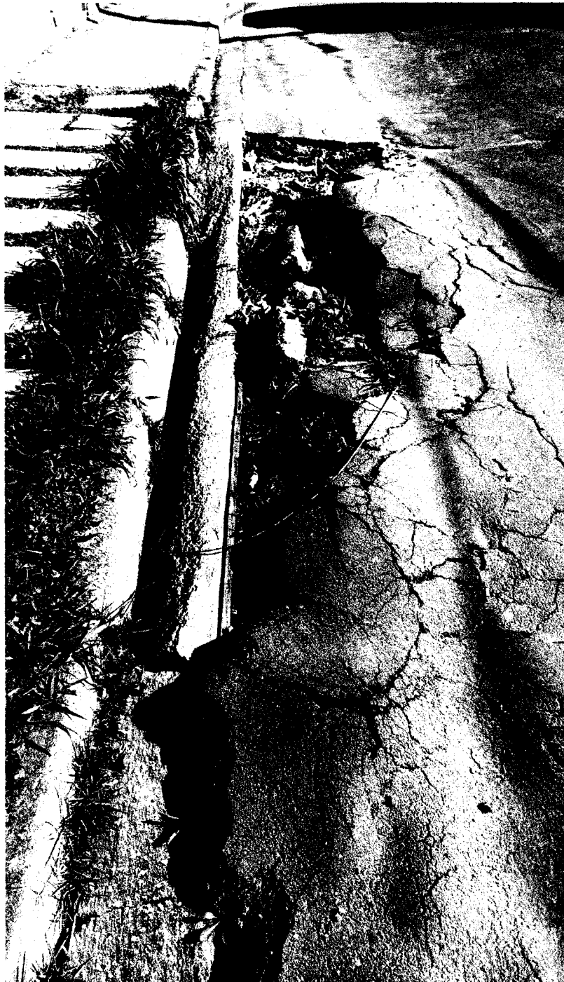
TAPA – BURACO NA RUA GUARAPIRANGA, EM FRENTE AO N° 585, JARDIM LAYR – MOGI DAS CRUZES.
