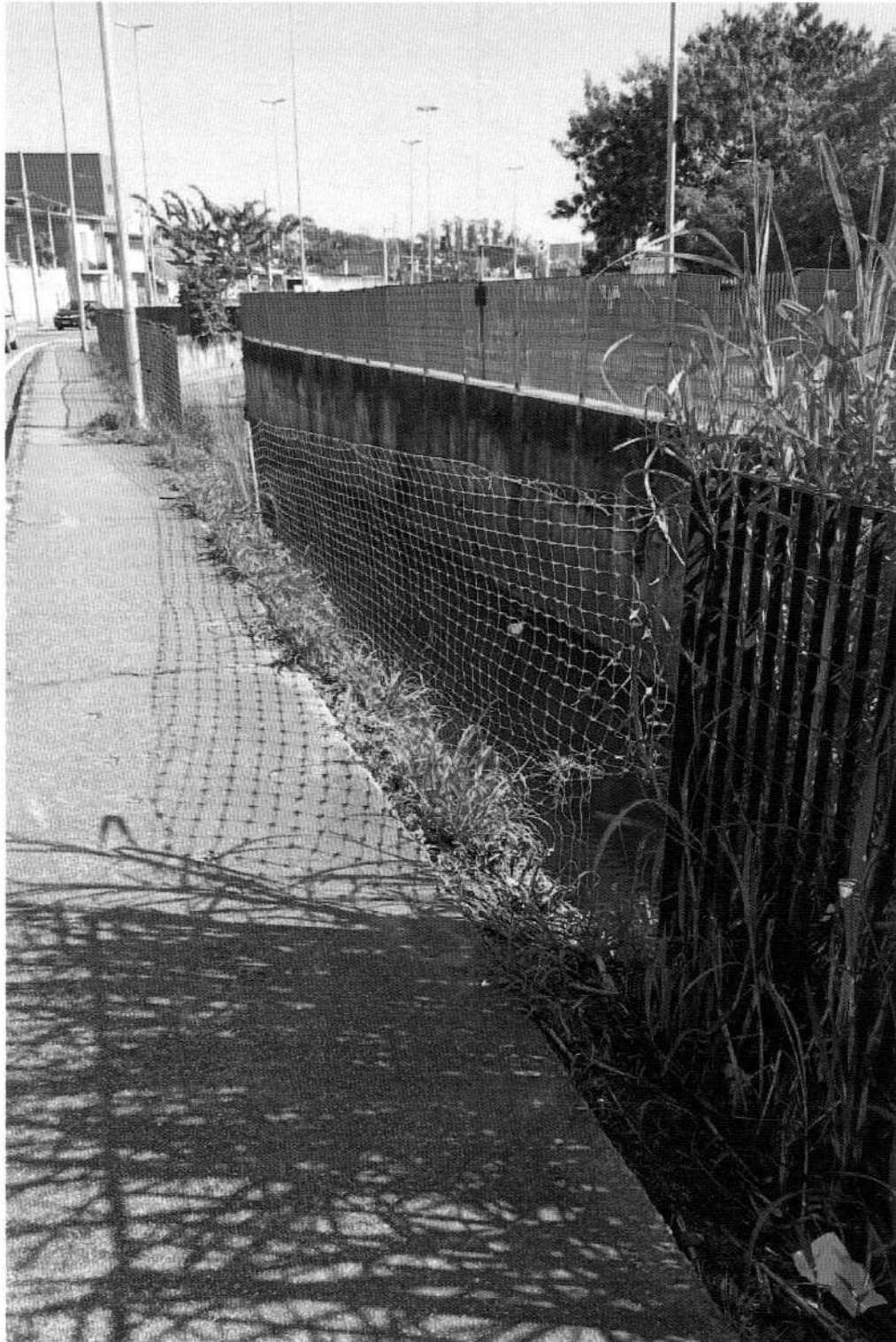
RECOLOCAÇÃO DO GRADIL NA AV. JÚLIO SIMÕES, EM FRENTE AO N° 1160, BRÁS CUBAS.
