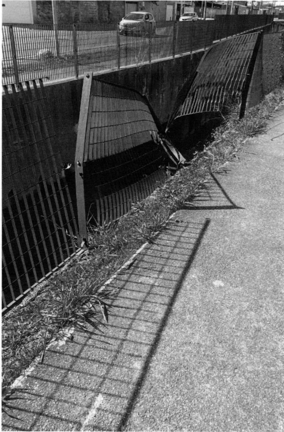
RECOLOCAÇÃO DO GRADIL NA AV. JÚLIO SIMÕES, EM FRENTE AO N° 667, BRÁS CUBAS.
