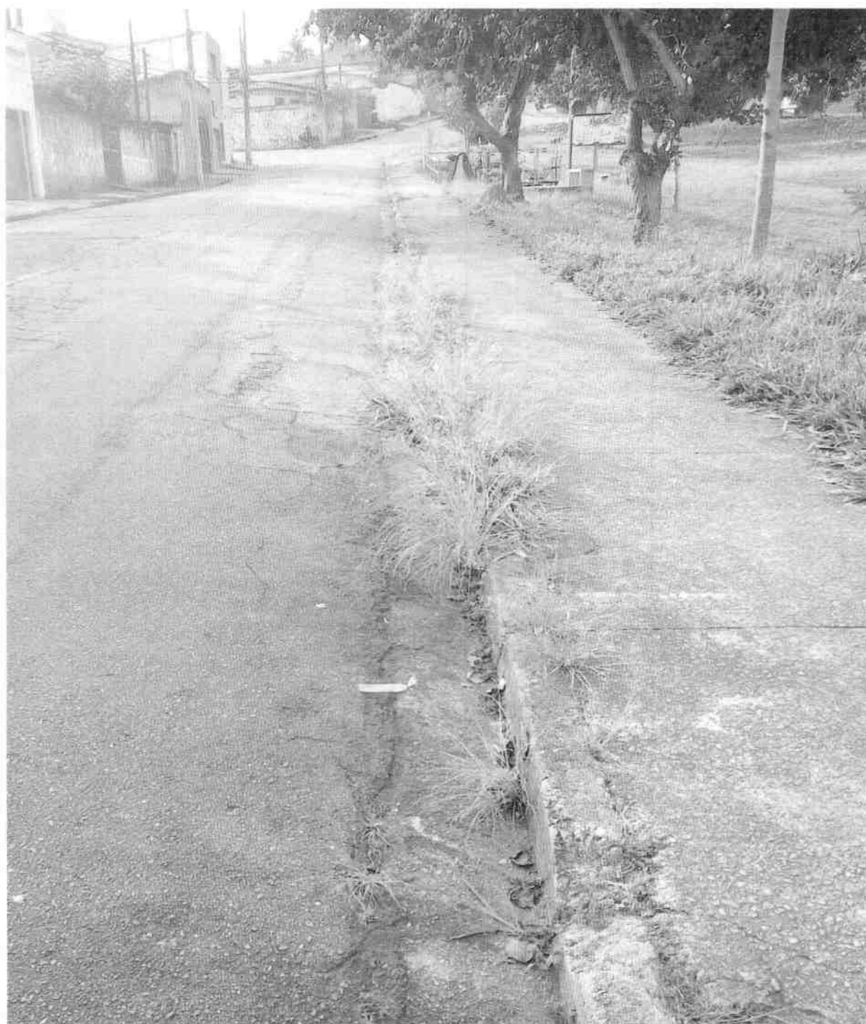
CAPINAÇÃO DE CABEÇAS DE GUIAS E RASPAGEM DE SARJETAS EM TODA A EXTENSÃO DA RUA SANTA LÚCIA, JARDIM CECILIA.
