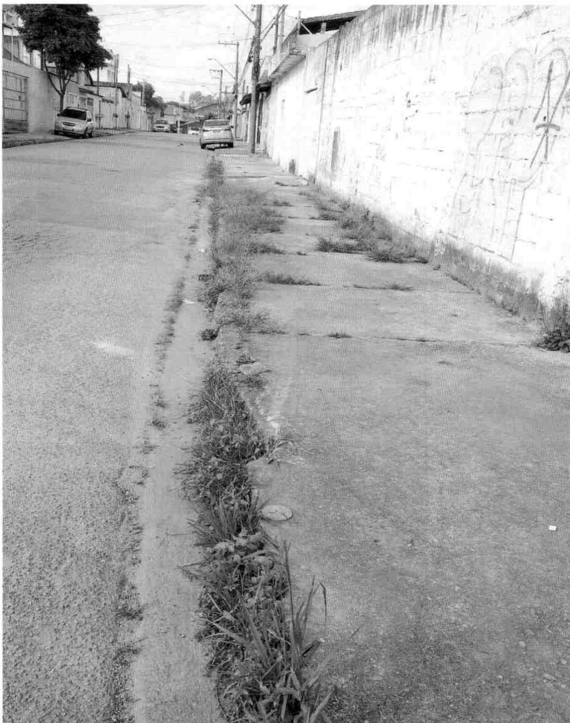
CAPINAÇÃO DE CABEÇAS DE GUIAS E RASPAGEM DE SARJETAS EM TODA A EXTENSÃO DA RUA SANTA TERESA, JARDIM CECILIA.
