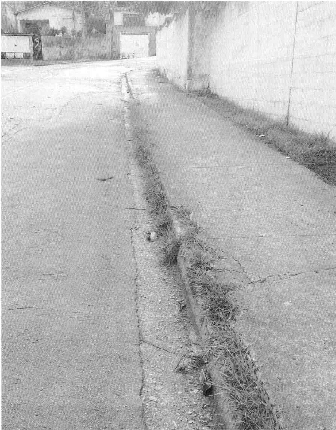
CAPINAÇÃO DE CABEÇAS DE GUIAS E RASPAGEM DE SARJETAS EM TODA A EXTENSÃO DA RUA JOSÉ FERNANDES FIGUEIRA, JARDIM CECILIA.
