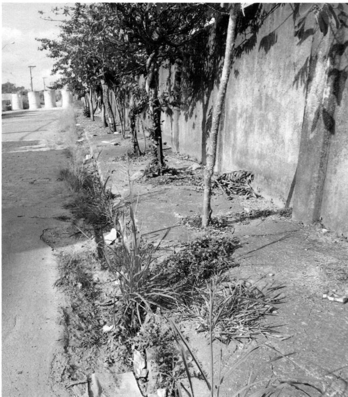
CAPINAÇÃO DE CABEÇAS DE GUIAS E RASPAGEM DE SARJETAS EM TODA A EXTENSÃO DA RUA MÁRIO PORTES, VILA SÃO FRANCISCO.
