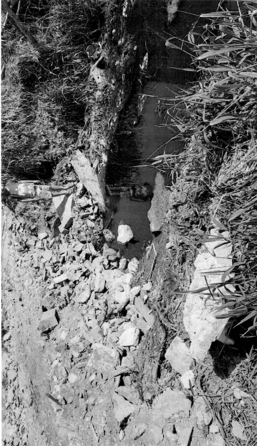
DESOBSTRUÇÃO DO MANILHAMENTO DE ÁGUAS PLUVIAIS NA RUA OCEANIA, EM FRENTE AO N° 908, JARDIM AEROPORTO III.
