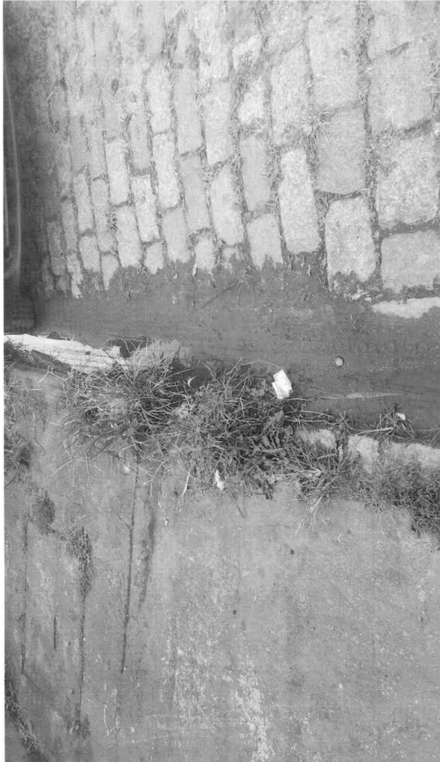
CAPINAÇÃO DE CABEÇAS DE GUIAS E RASPAGEM DE SARJETAS EM TODA A EXTENSÃO DA RUA DOS SONHOS, VILA SÃO FRANCISCO.
