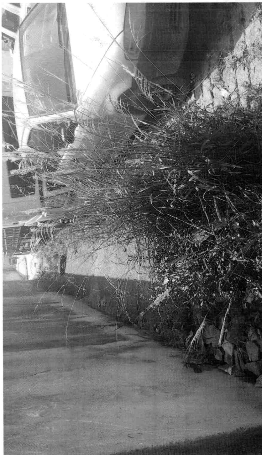
CAPINAÇÃO DE CABEÇAS DE GUIAS E RASPAGEM DE SARJETAS EM TODA A EXTENSÃO DA RUA OSVALDO SCOGNAMIGLIO, VILA SÃO FRANCISCO.
