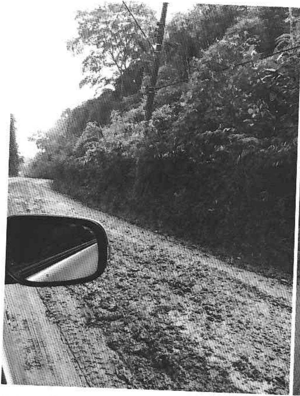
Colocação de Fresa asfáltica na Estrada Santa Rita, bairro Vila Moraes
